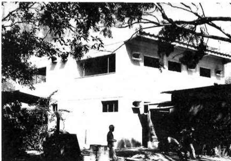
Construção do Prédio de Laboratórios (ELC), principal marco da presença do Curso de Comunicação Social no CCJE
