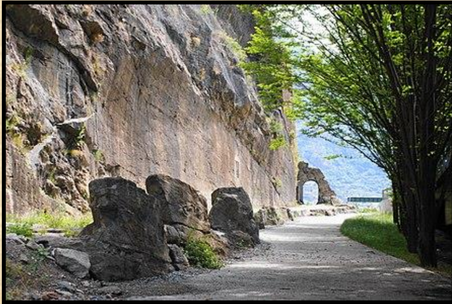
Seção da Via delle Gallie Valle d'Aosta), construída ao cavar a encosta íngreme de rocha
