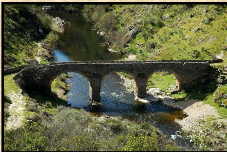
Ponte romana de Algozo, sobre a ribeira da Ponte - Portugal
