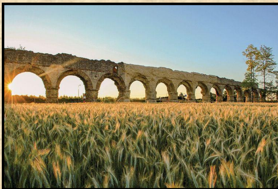
Aqueduto de Gier em Chapónot-França, construído a partir do chorobate (fonte: https://strapi-upload.cdn.fondation-patrimoine.org/medium_156727_yxc1ne2ql8_whr_e902212beb.jpg )
